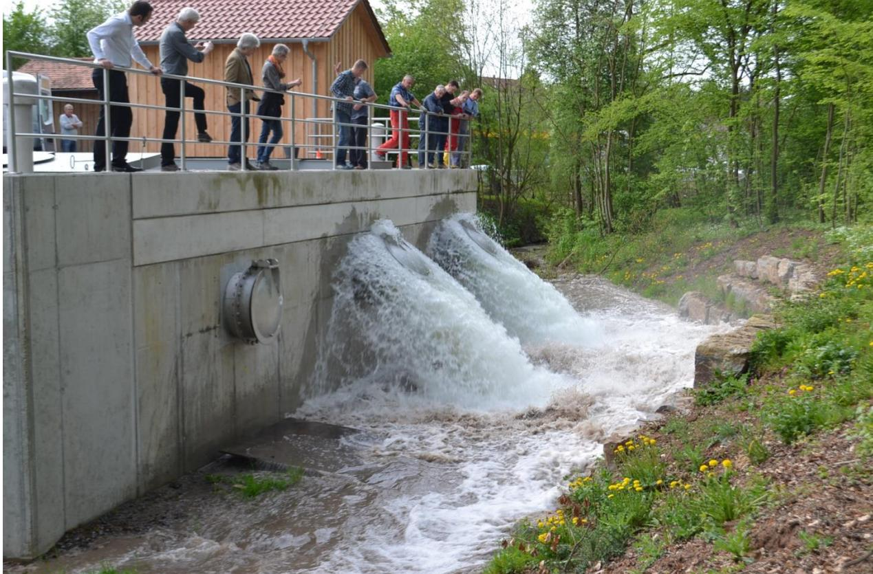
Das System von Dämmen und Mauern wurde in den Jahren 2014/2015 ergänzt durch Hochwasserpumpwerke, um die Ortskanalisation zu entlasten.
